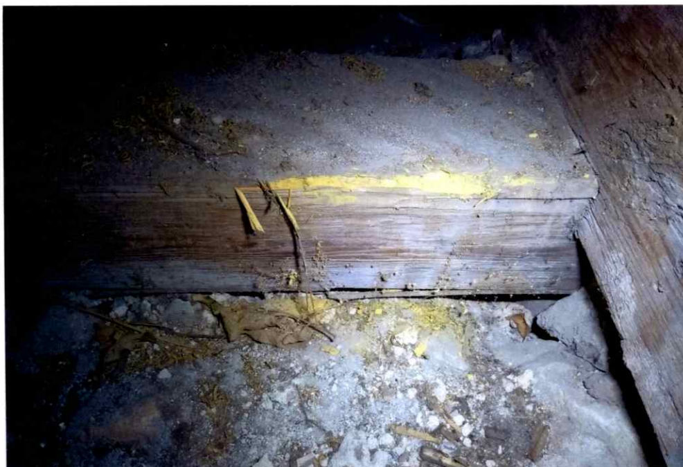
foto č. 4 - krátký vazný trám, patrna činnost Tesaříka krovového
