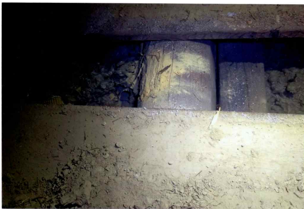
foto č. 2 - stropní trám poškozen Tesaříkem krovovým
