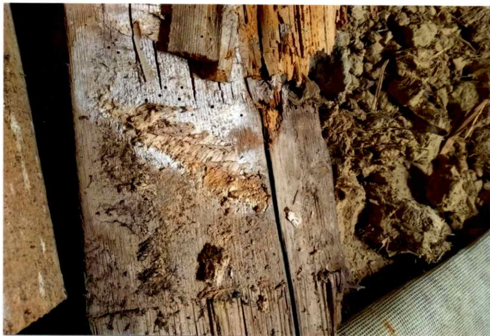
foto č. 7 - silné poškození stropního trámu Outkovkou řadovou a Červotočem proužkováním
