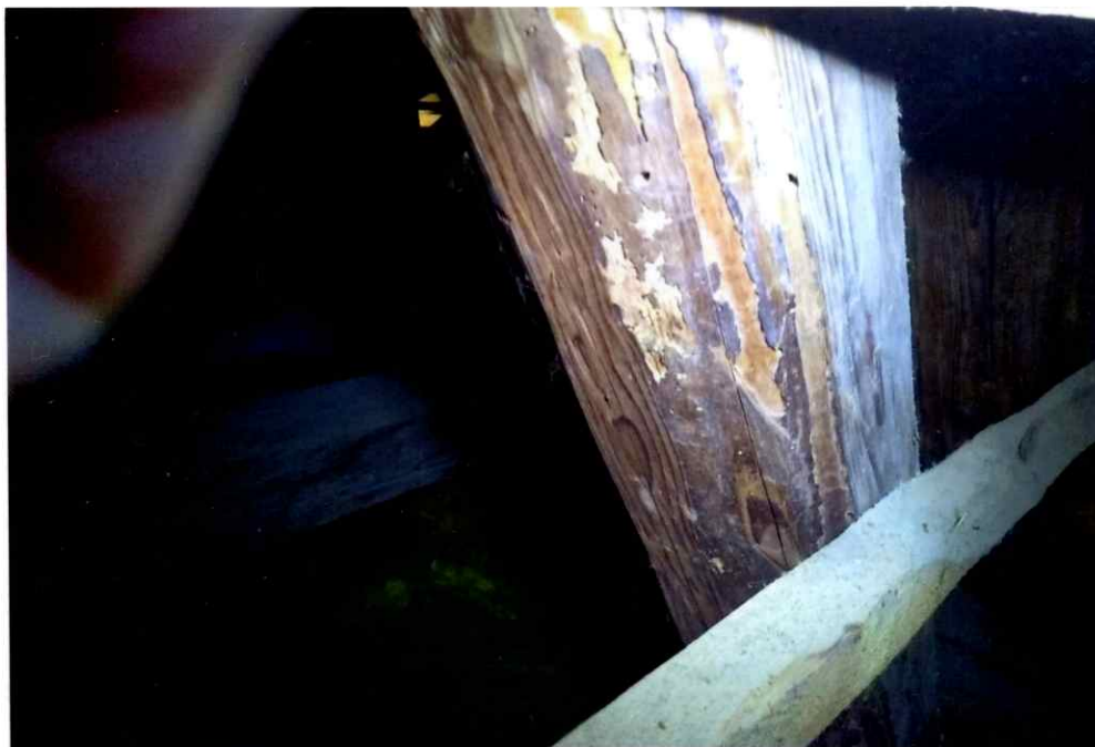
foto č. 3 - šikmá vzpěra, známky činnosti Tesaříka krovového
