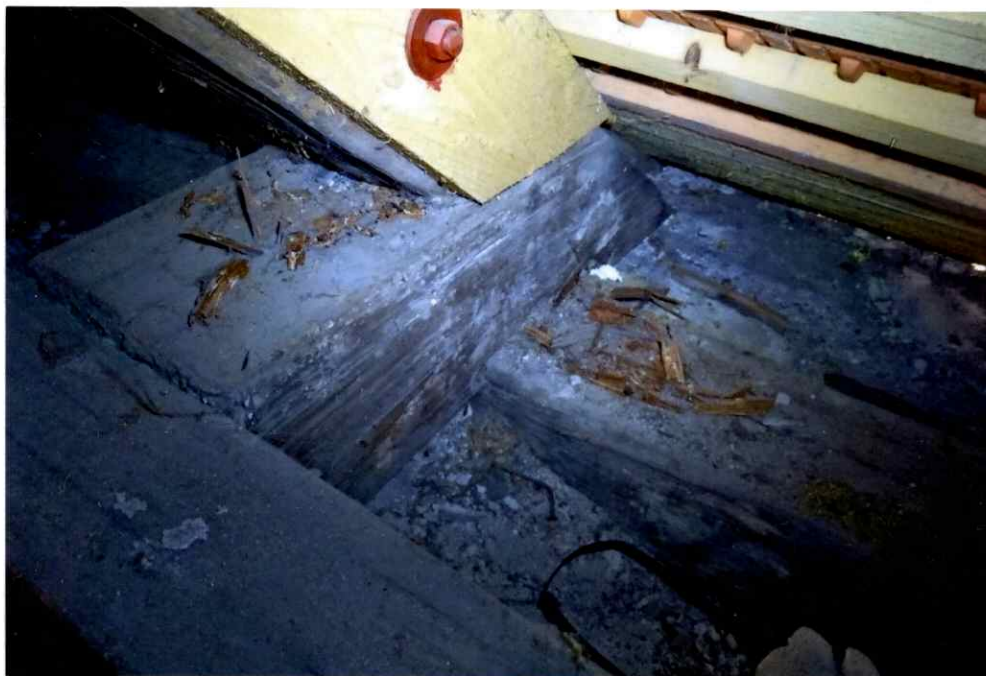
foto č. 5- zhlaví krokve, část pozednice a krátký vazný trám poškozeny silně hnědou hnilobou
