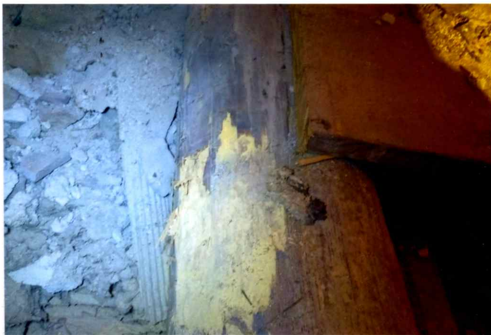
foto č. 8 - silné, aktivní poškození stropního trámu Tesaříkem krovovým
