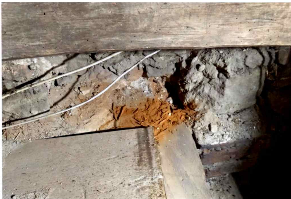
foto č. 9- silné poškození hnědou hnilobou ve zhlaví stropního trámu
